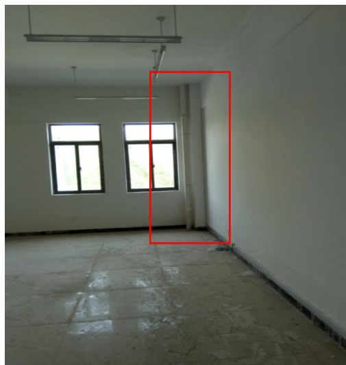
楼层排水管道
