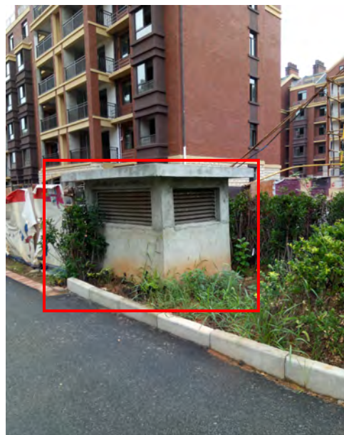
地下车库排风口
