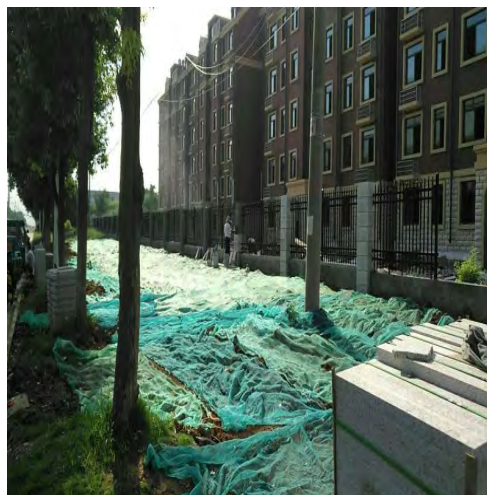
施工期裸露地面覆盖抑尘
