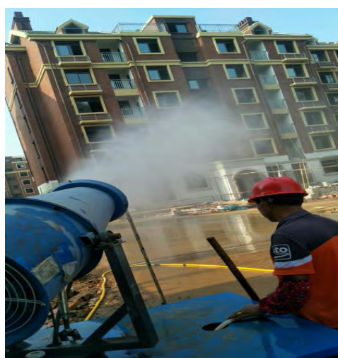
施工期雾炮机喷雾降尘
