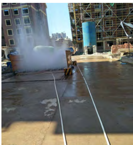
施工期车辆进出清洗
