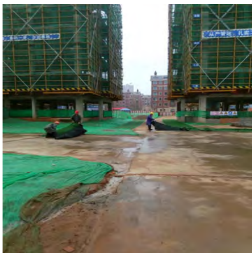
施工期裸露地面覆盖抑尘
