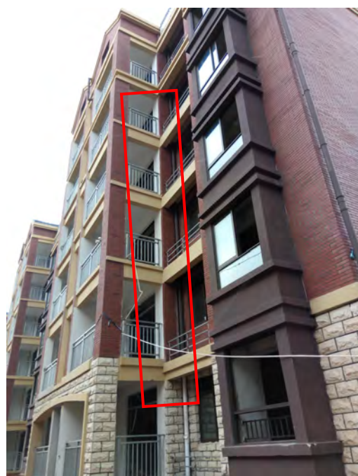
住宅楼雨水管道
