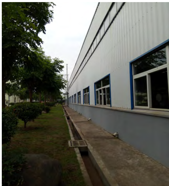
车间外排气筒
