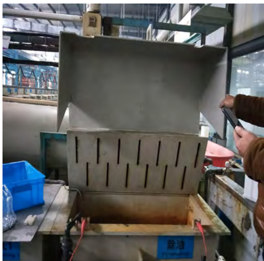
前处理酸洗槽加盖
