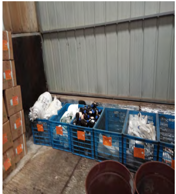
危废库地面的防渗处理
