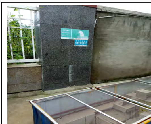
污水处理站排口
