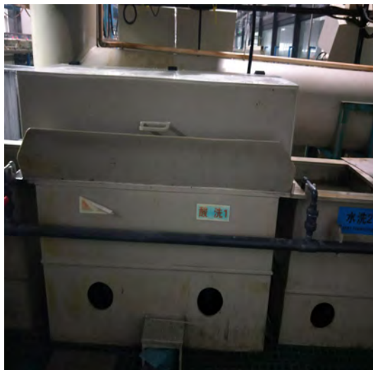
前处理酸洗槽加盖
