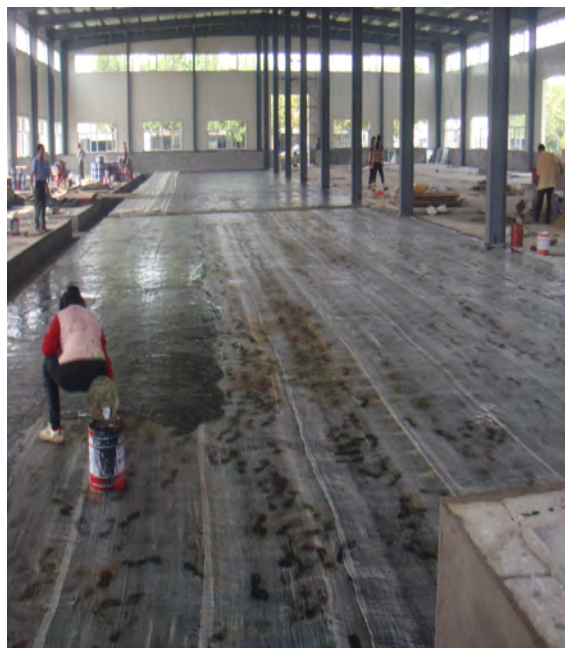
电镀车间建设时地面刷高分子聚氨酯防水材料
