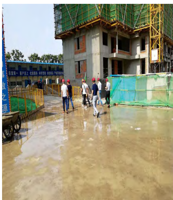
施工期裸露地面覆盖抑尘
