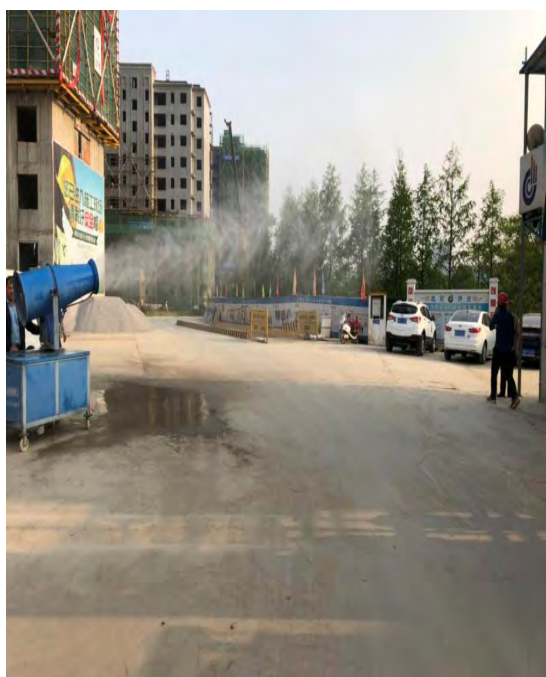
施工期雾炮开启抑尘
