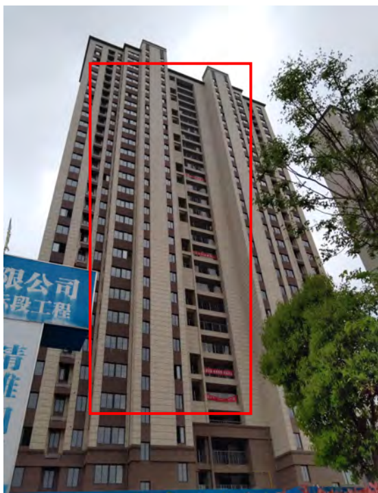
临近迎宾大道一侧住宅楼双层玻璃
