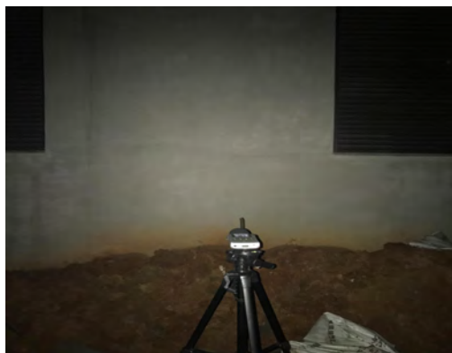
1#开闭所北侧夜噪
